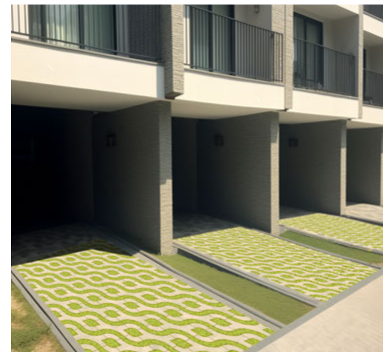
파킹숲 시공후 잔디 식재 현장
