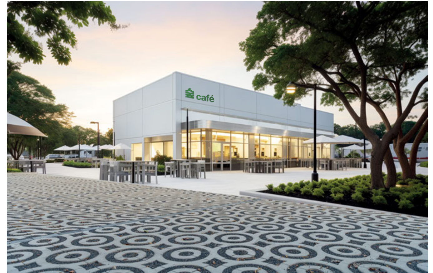
파킹숲 시공후 자갈 포설 현장
